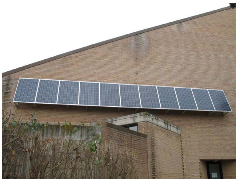
Figura 24 - Esempio di installazione non idonea alla classificazione dell'impianto fotovoltaico nella categoria "su edifici" – Motivazione: la struttura collegata non sottende superfici trasparenti
